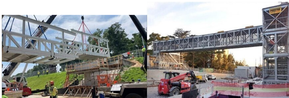
תמונה: גשרים זמניים מודולריים המאפשרים תנועת הולכי רגל מעל אתר עבודה. (למטרות המחשה בלבד)
