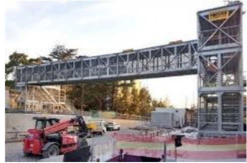
תמונה: גשרים זמניים מודולריים המאפשרים תנועת הולכי רגל מעל אתר עבודה. (למטרות המחשה בלבד)
