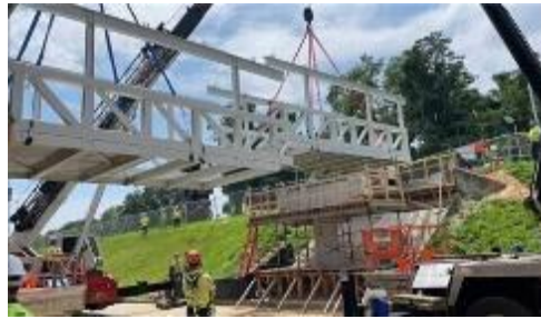
תמונה: גשרים זמניים מודולריים המאפשרים תנועת הולכי רגל מעל אתר עבודה. (למטרות המחשה בלבד)
